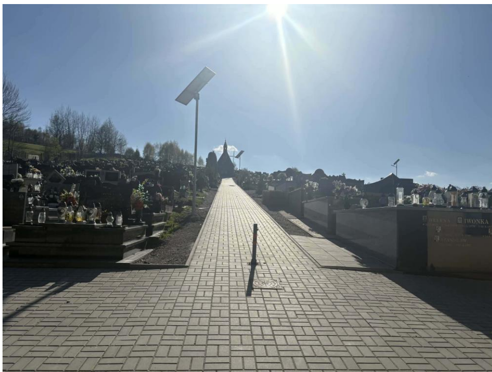
Wykonanie chodnika na cmentarzu komunalnym w Pewli Ślemieńskiej
